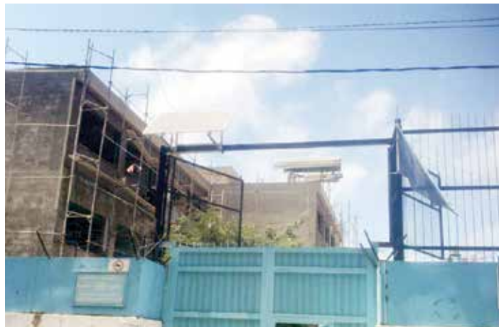
ورشة الترميم والبناء في مدرسة حيفا
